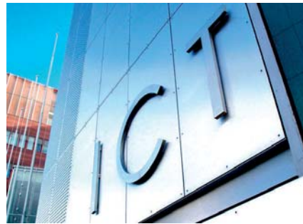
ICT-talon julkisivuteksti, alumiinikotelot, Turku
